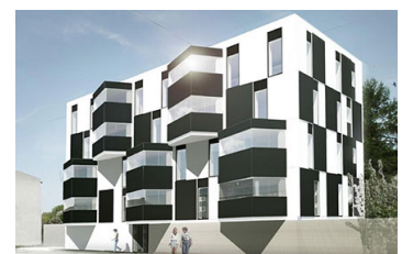
Housing+, Dinamarca. 1ª casa sustentável com a bateria VisBlue
