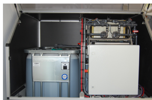
Interior de uma bateria VisBlue
